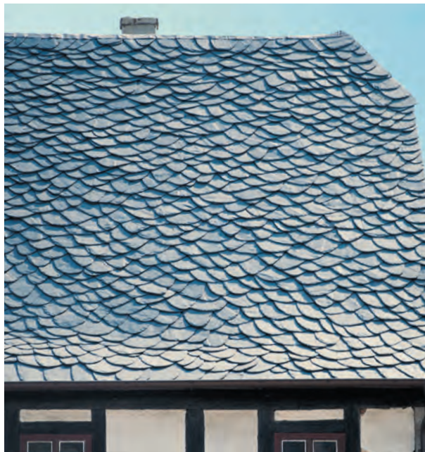
スレートで葺かれた屋根
